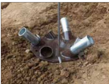
4 鋼管杭の打ち込み完了
