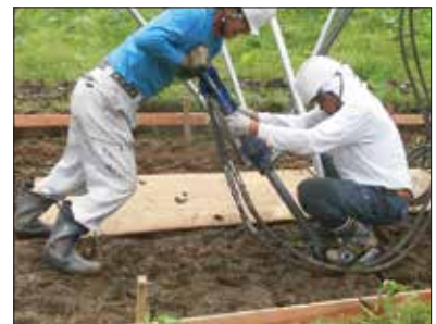
3 鋼管杭の打ち込み
