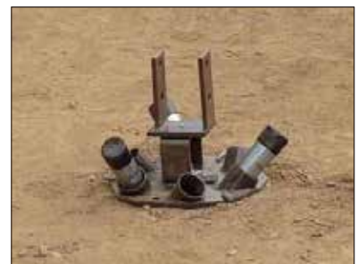
6 C-LESS基礎 設置完了
