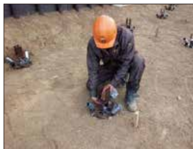
5 連結金具の取付け
