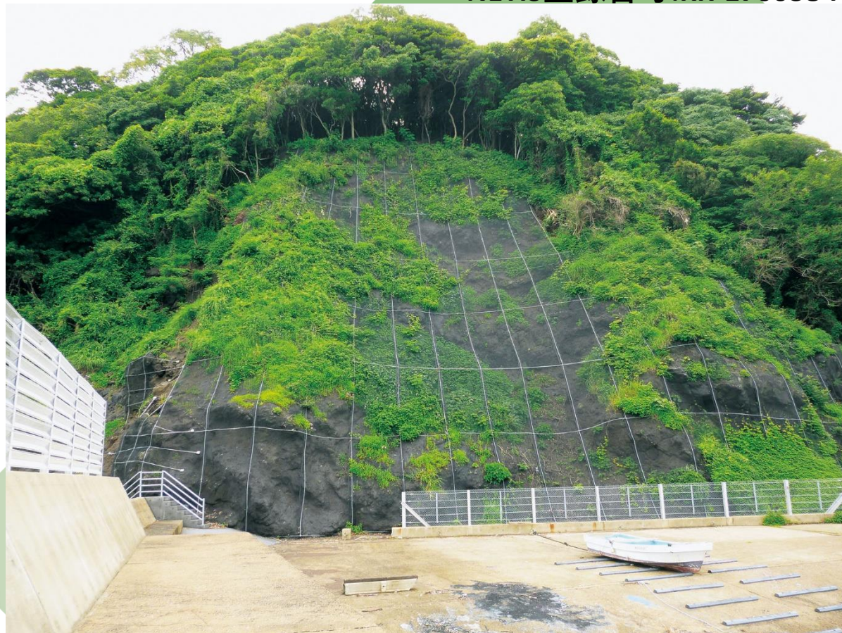
覆式落石防護網工
