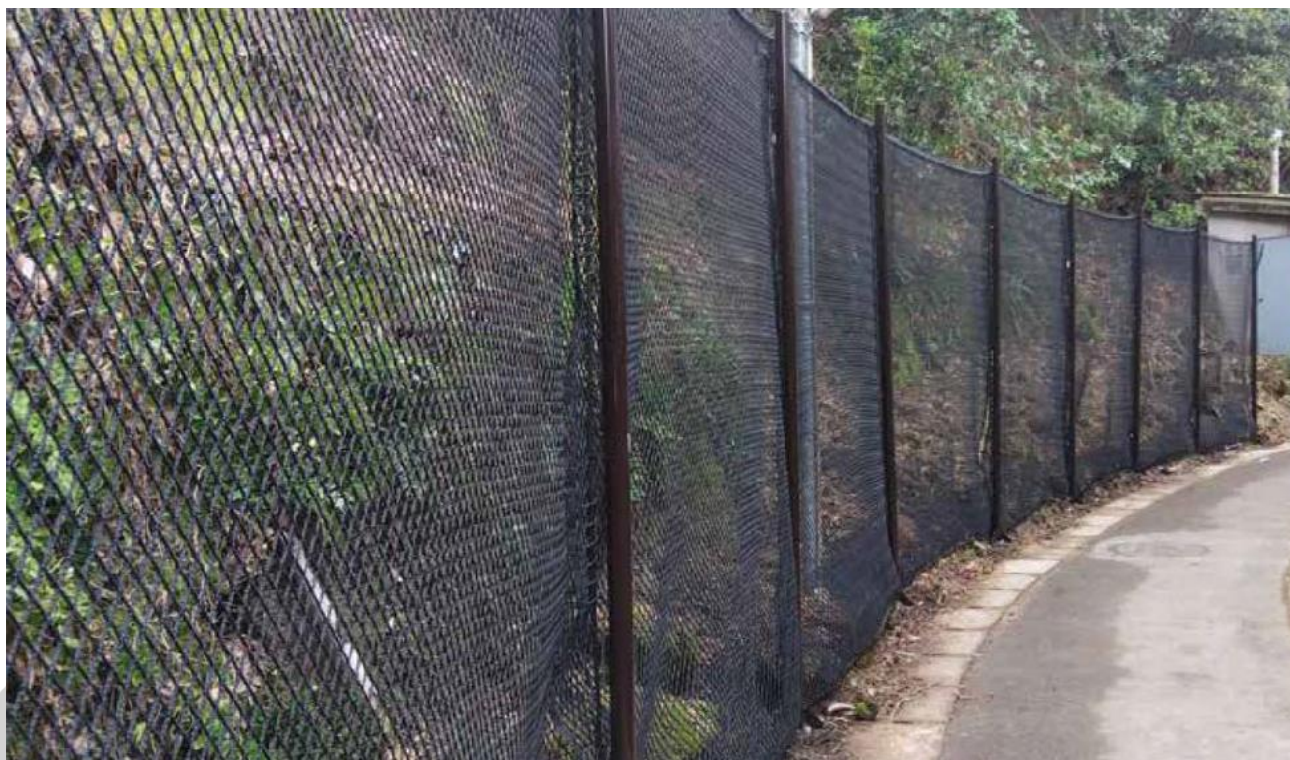
簡易落石防護柵工
