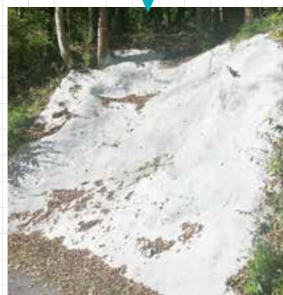
モルタル吹付面経過観察 (5 か月後)
