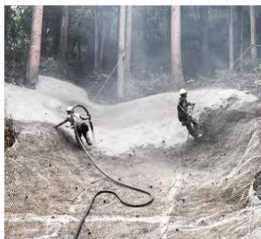
モルタル吹付の様子
