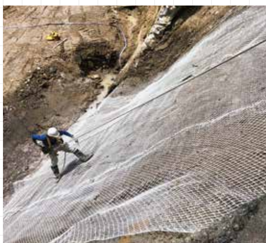
プラス網敷設の様子
