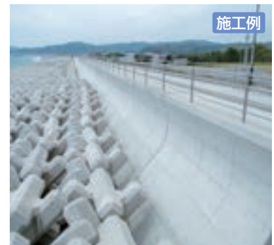
高知県 平成 24 年 仁ノ海岸堤防改良工事
