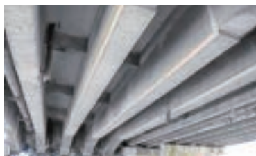
RC主桁の補強
