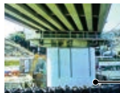
耐震補強・コンクリート巻き立て工
