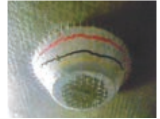
押抜き試験状況
