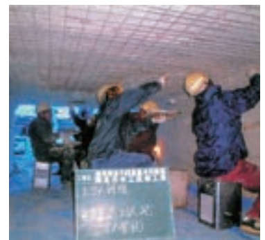
ボックスカルバートの頂版補強
