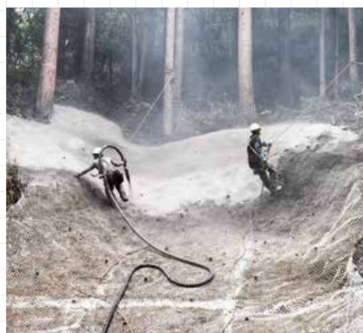
モルタル吹付の様子
