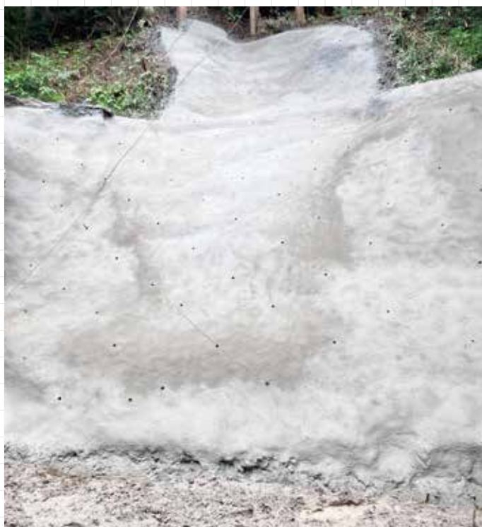
モルタル吹付後の様子
