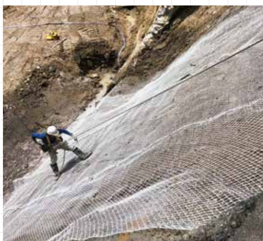
プラス網敷設の様子
