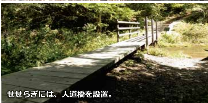
橋の高欄は、プラ擬木製の角材柵で改修。
