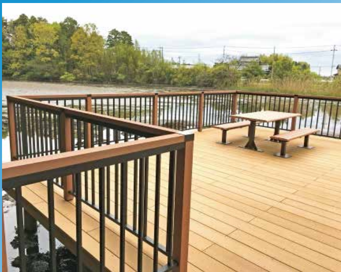
【事例1】床板・転落防止柵：Kankyo-wood II 構造材：アルミ
