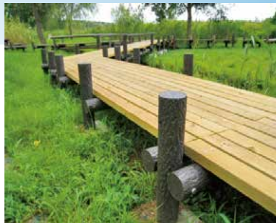
【事例6】床板：天然木 構造材：プラ擬木
