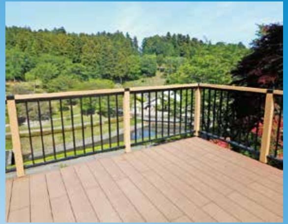
【事例4】床板・転落防止柵：Kankyo-wood II 構造材：アルミ合金
