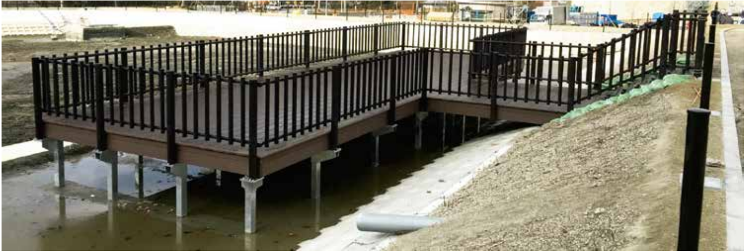
大阪府交野市 『 四交クリーンセンター 』
