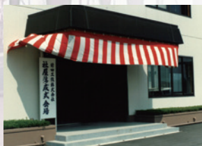
春江本社工場新築
