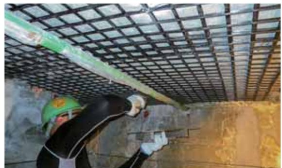
接着系あと施工アンカー(回転・打撃タイプ)
