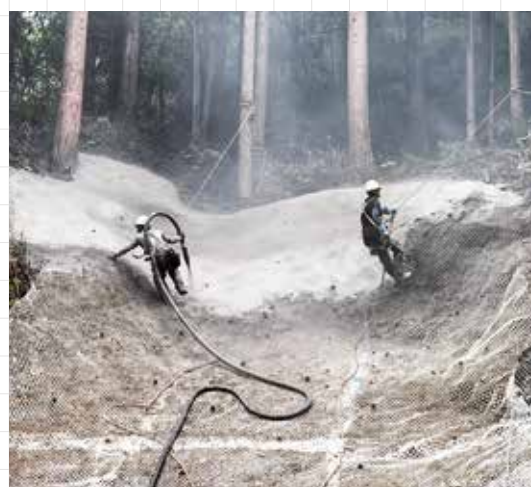
モルタル吹付の様子
