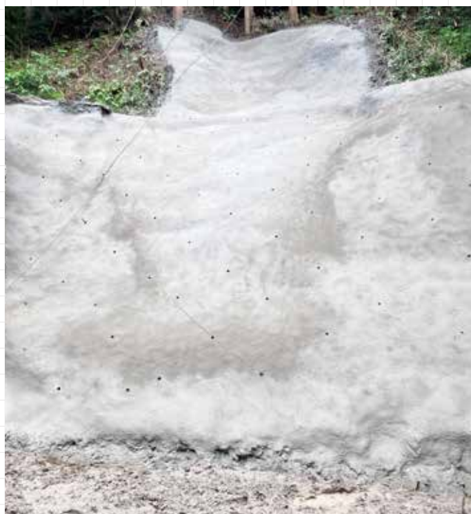
モルタル吹付後の様子
