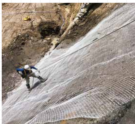
プラス網敷設の様子
