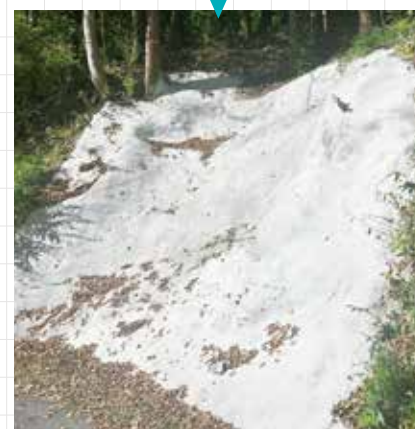
モルタル吹付面経過観察 (5 か月後)
